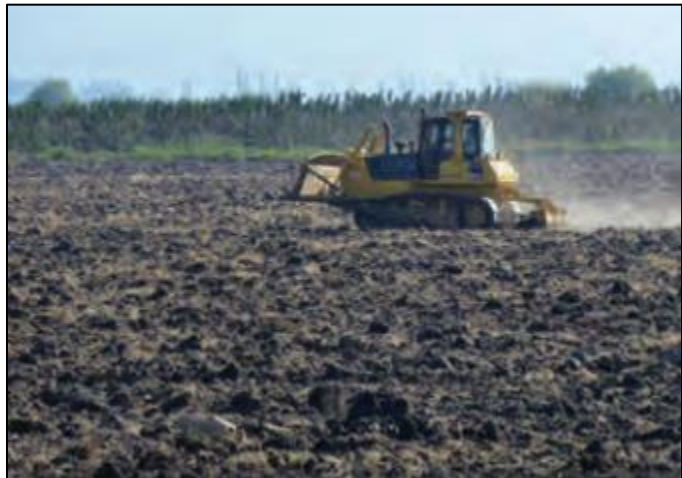
Figura 3. Bulldozer D8, trabajando a un metro de profundidad. Foto: Seguel, 2010.
